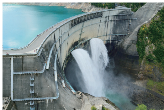
ダム ほうすい の放水
